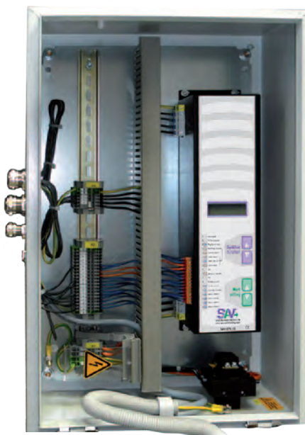
Steuerung im Schaltkasten
