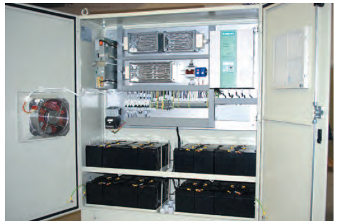
Устройство аварийного питания BBU
